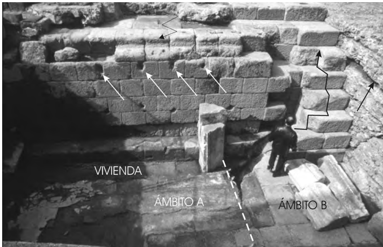
Figura 13. Adosamiento de una vivienda de dos plantas al templo del llamado Foro Provincial. Se indican las improntas de las vigas, rebajes, rozas, etc. y el acceso al piso alto.
